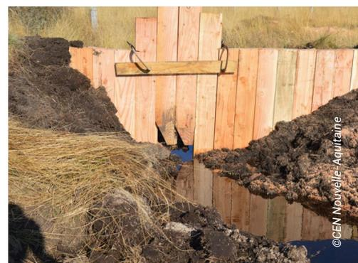
drain principal pour le neutraliser. Longues de 20 à 35 m, elles ont été recouvertes d'une couche de végétation prélevée sur place pour renforcer l'étanchéité de la structure et favoriser l'intégration paysagère. L'écoulement se fait désormais de manière diffuse, en périphérie des palissades.
