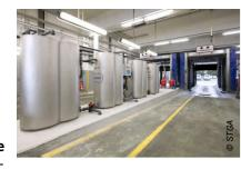
station d'épuration », des eaux de lavage pour les réutiliser en circuit fermé. Les eaux récupérées dans le tunnel de lavage sont évacuées vers une succession de filtres, de collecteurs de décantation et finalement dans une centrifugeuse permettant l'élimination des boues et impuretés supérieures à 5 microns. Un traitement biologique par bactéries naturelles finalise le processus d'épuration.
