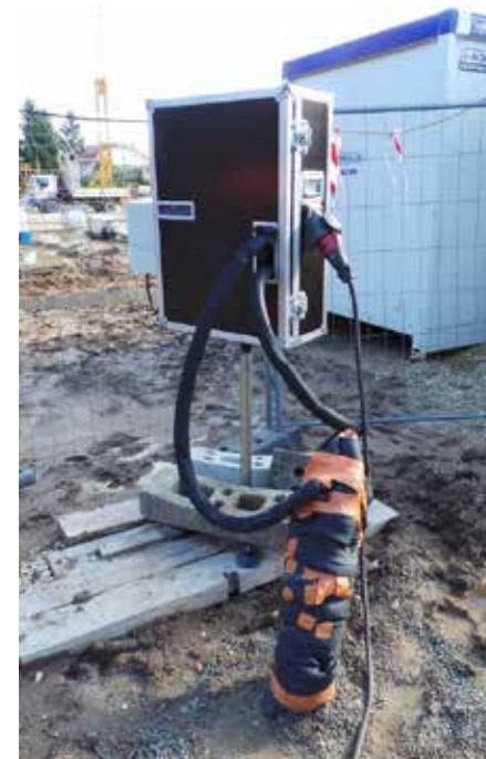
Sonde sèche pour évaluer le potentiel calorifique d'une ressource géothermique
