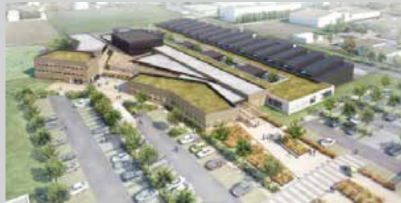
Vue d'ensemble du pôle de l'écoconstruction charentais, vitrine des nouveaux enjeux du BTP
