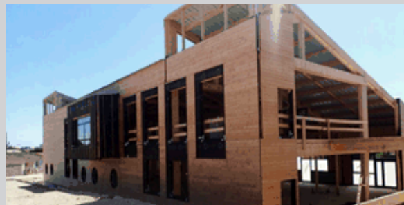
Étape de construction de la façade modulaire en ossature bois type perspirants du CFA, permettant l'autorégulation de l'hygrométrie du bâtiment
